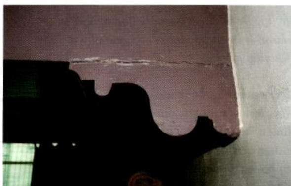
Afb. 17) Foto van de fraaie consoles onder de moerbalken van de zoldervloer in het voorhuis en opmeting van de consoles in het zijhuis. (Tekening en foto: auteur)
